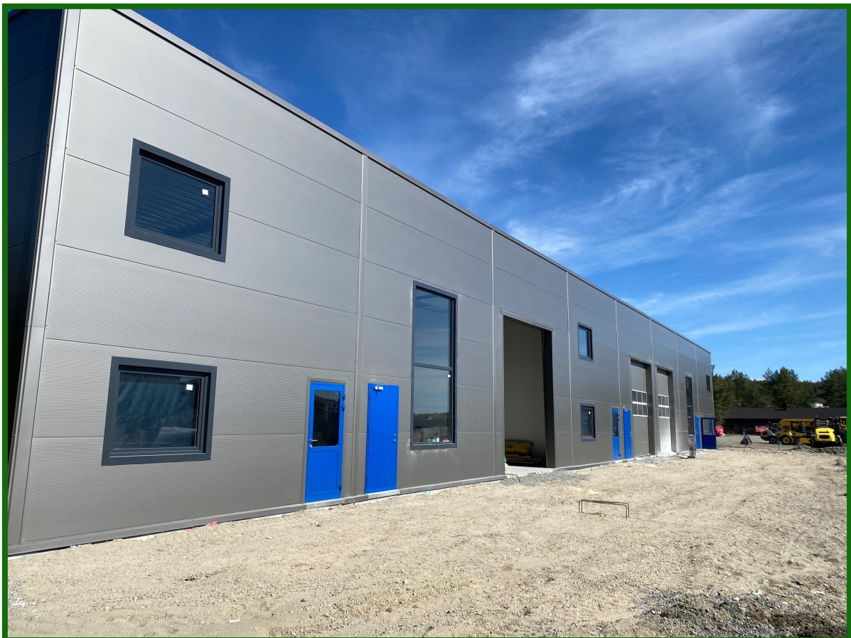
Bilde fra byggeplassen Mai 2022
